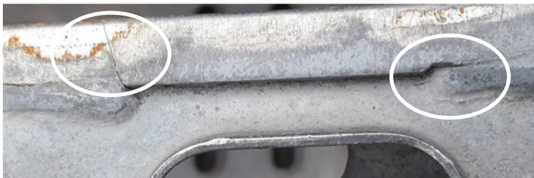
Muldenbalken: Rissbildung bei Schweißnähten
