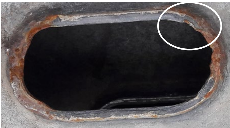
Kotflügelblech: Materialabtragung durch Fließen
